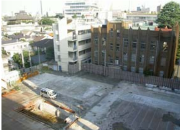
旧C館、S館一部(西側)解体跡
