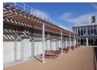
校舎棟：ウッドデッキ
